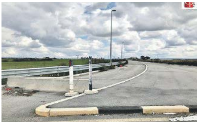
Lo svincolo della strada Talsano - Avetrana da dove partiranno i lavori di ampliamento.
