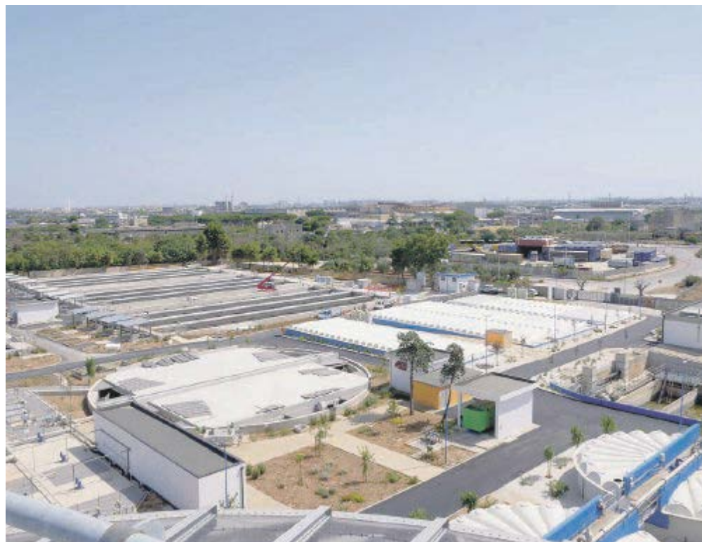
I lavori cominceranno dal depuratore di Bari Ovest
