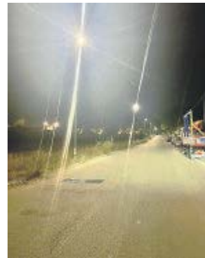
Nell'intervento è compresa la pulizia dell'intera area
